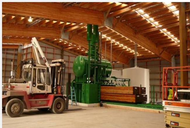
Planta Impregnadora Vacío/Vacío con producto VACSOL AZURE (RTU)
