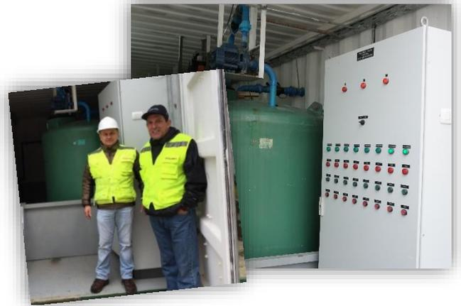
mediante un PLC determina y dosifica los rellenos con productos antimanchas y agua, manteniendo la concentración deseada en forma constante, evitando de ésta manera la manipulación de los químicos por parte de los operadores. Este sistema entró en funcionamiento el año 2017 y hasta el día de hoy es utilizado exitosamente.
